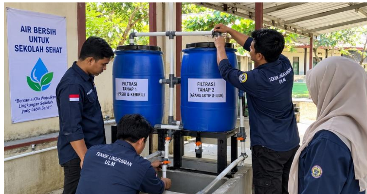
Gambar 3. Proses Instalasi Modul Filtrasi Sederhana
